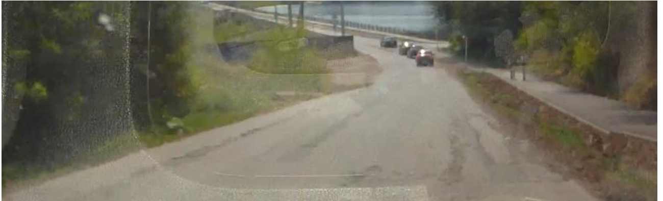
Рисунок 3.26 – Спуск с ул. Северной в направлении плотины
