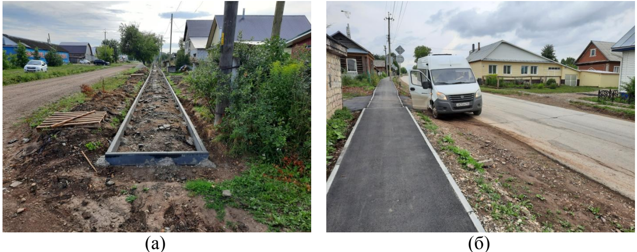
Рисунок 1.22 – Строящиеся и новые тротуары в р.п. Суксун: а – ул. Маношина; б – ул. Северная.
